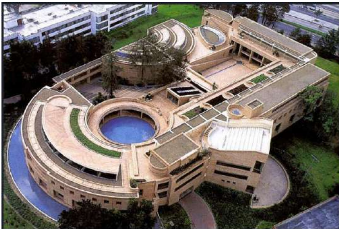
Figura 98. Vista aérea del edificio Rogelio Salmona de posgrados de la Facultad de Ciencias Humanas.
