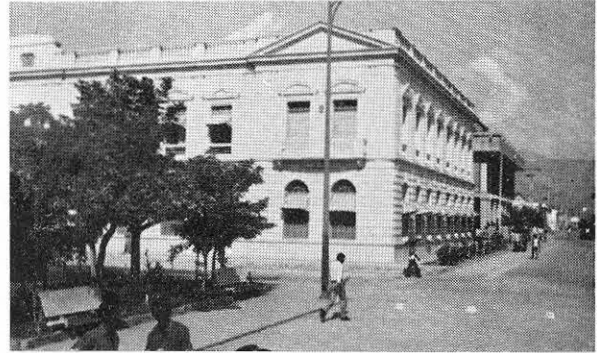
CIÉNAGA. — Parte del edificio de la alcaldía y demás oficinas públicas.
