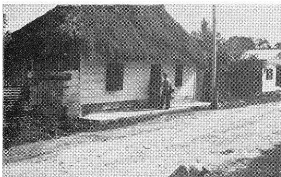
ARACATACA. — Un estilo de casa: paredes de tablas y techo de palma.
