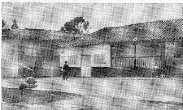
La casa retocada y mayormente la de dos plantas, en la plaza de Siachoque, mantienen el predominante estilo colonial.
