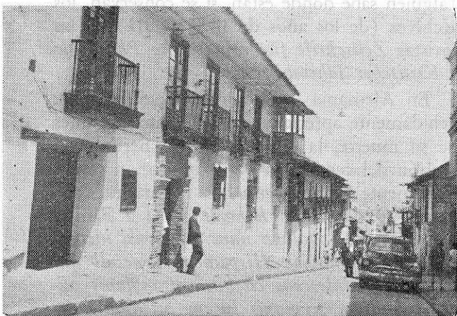
Balcones de casas antiguas en el barrio de La Candelaria (calle 10).
