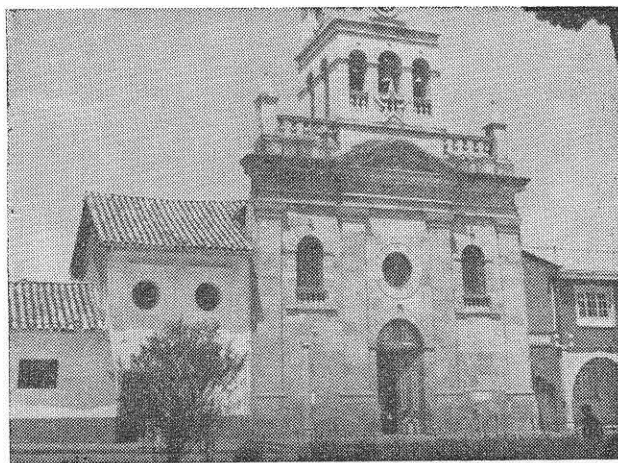
LA CALERA. — Iglesia de la población.
