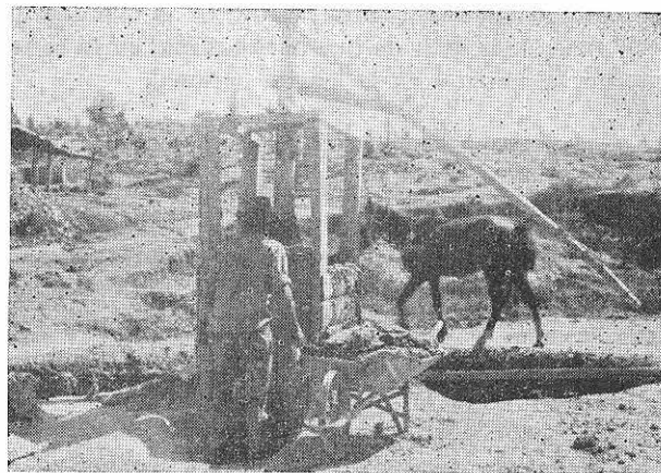
Moliendo barro para hacer ladrillo.
