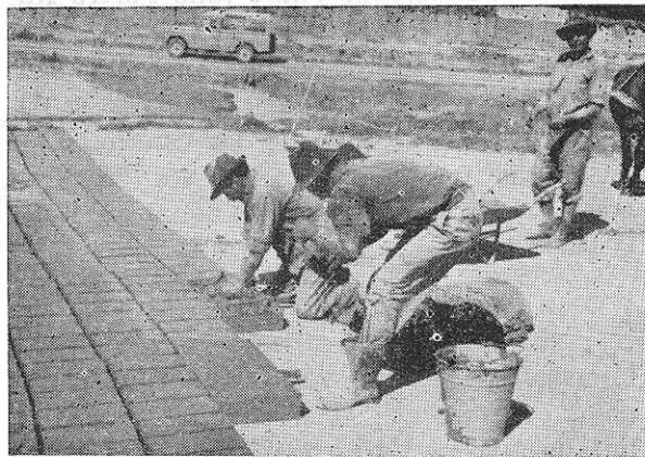
"Cortando" ladrillo (moldeando).
